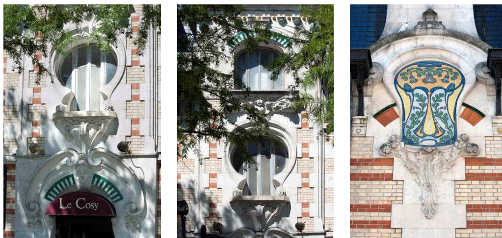
Vues de détails des baies et des mosaïques © Région Centre-Val de Loire, Inventaire général, Thierry Cantalupo
