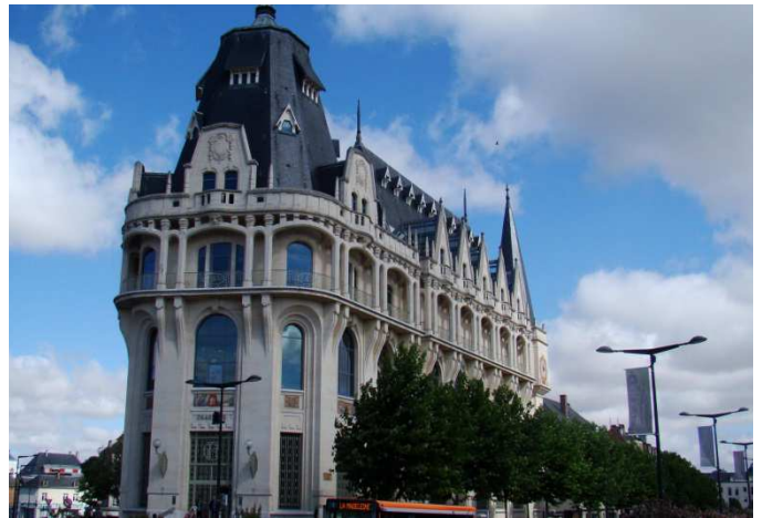
Façade de l'Hôtel des Postes côté boulevard et vu de la place des Epars, Photographies : Virginie Muller
