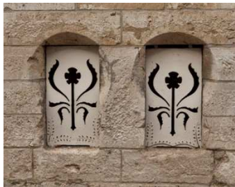
Vue de la porte d'entrée et vue de détail des soupiraux © Région Centre-Val de Loire, Inventaire général, Thierry Cantalupo
